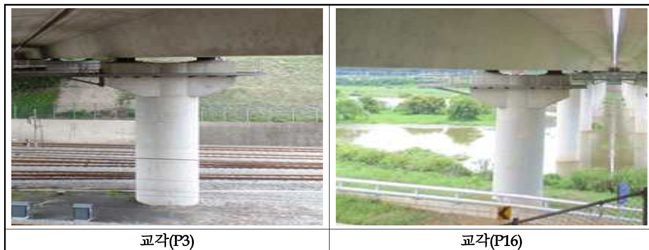
【사진 3.2.7】 교각 전경(대구)
