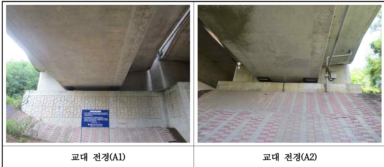
【사진 3.2.5】 교대 전경(대구)
