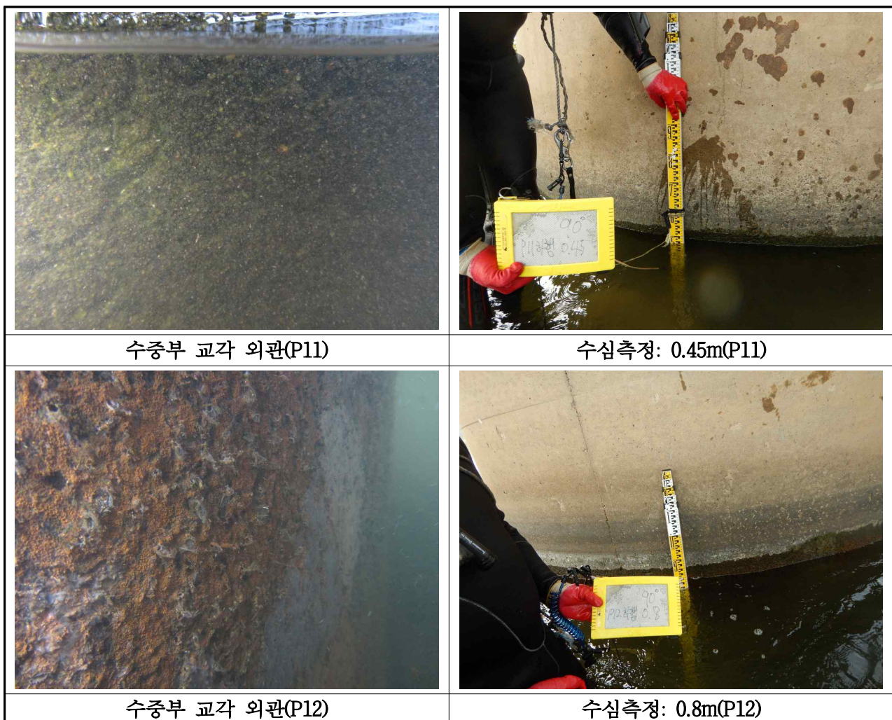
【사진 3.3.9】 교각 수중부 조사 현황(부산)
