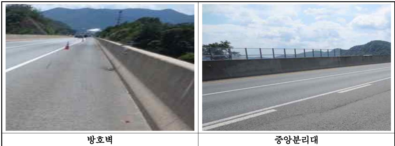
【사진 3.3.19】 난간 및 연석 전경(부산)
