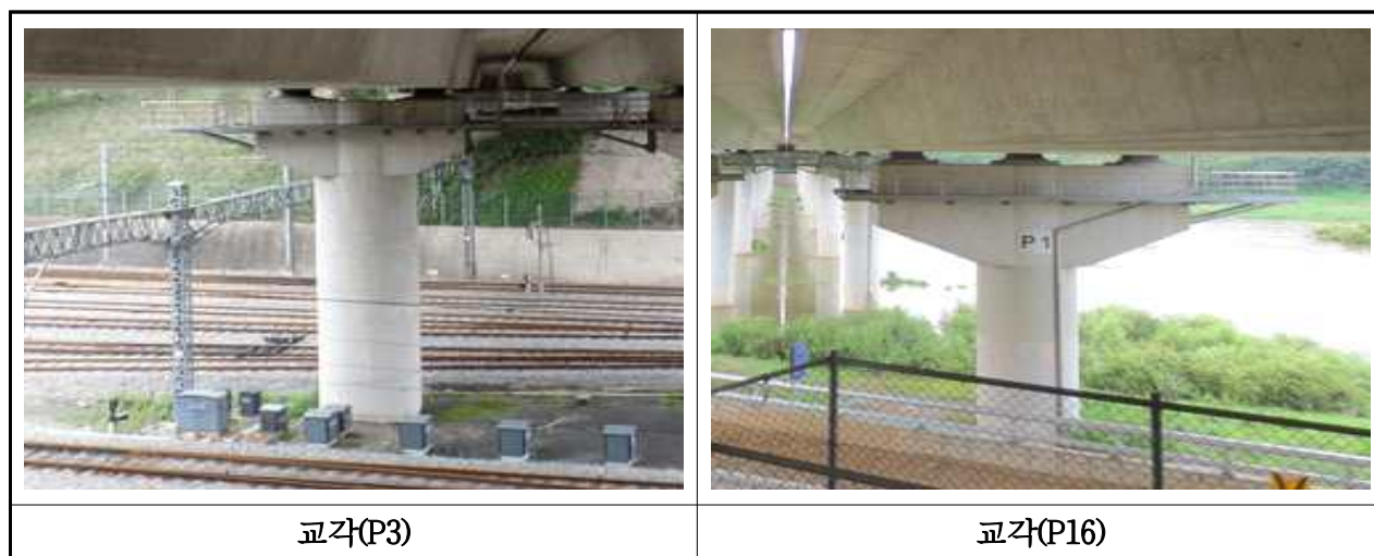
【사진 3.3.7】 교각 전경(부산)
