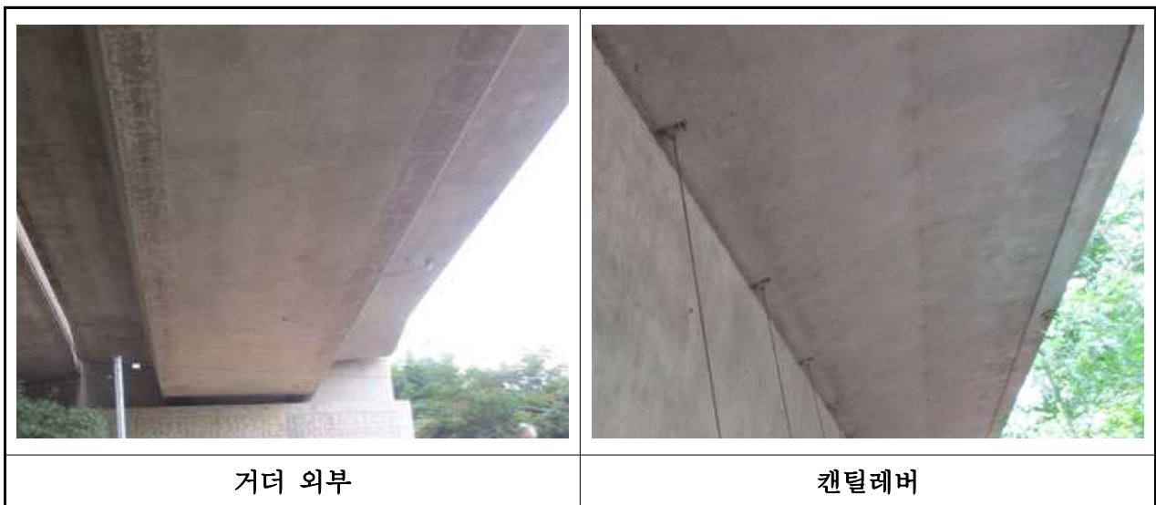
【사진 3.3.1】 거더 외부 전경(부산)
