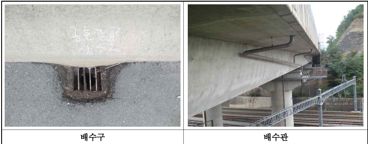
【사진 3.2.17】 배수시설 전경
