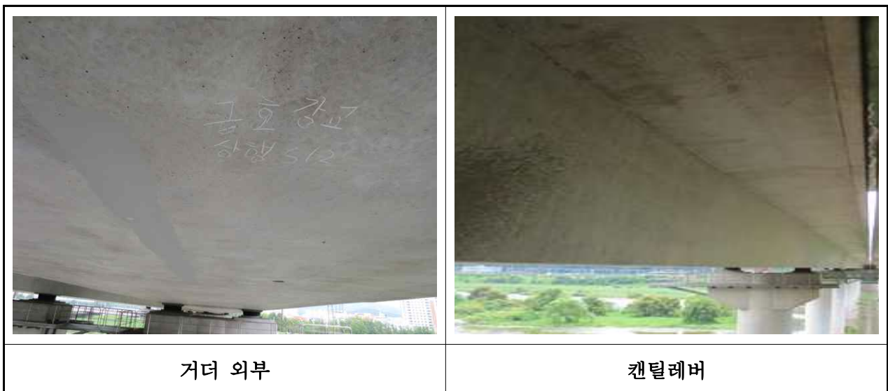
【사진 3.2.1】 거더 외부 전경(대구)
