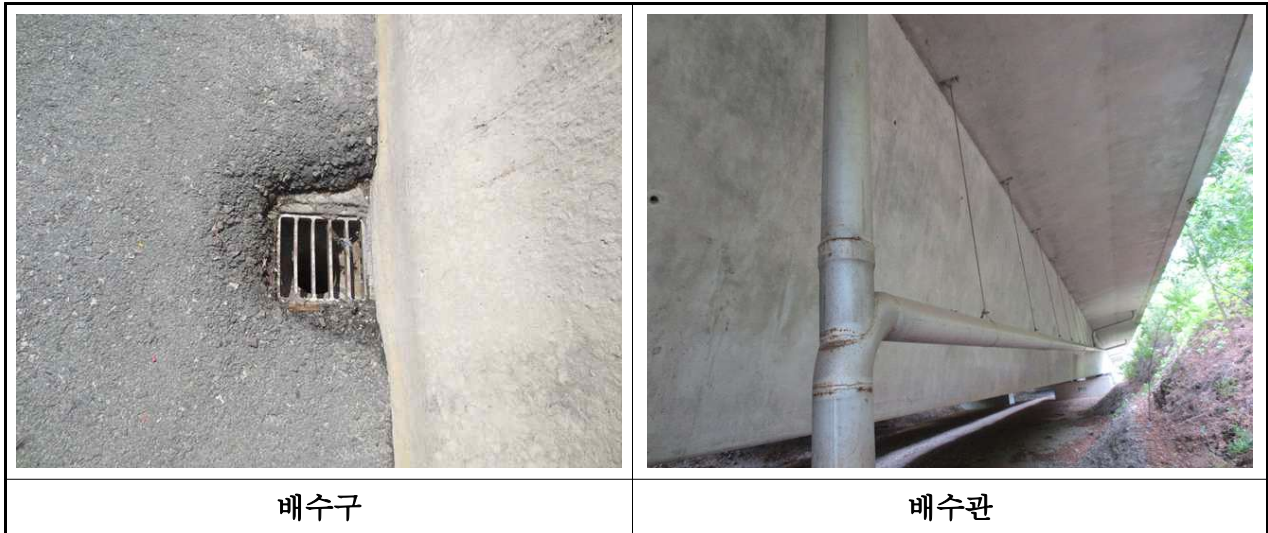
【사진 3.3.17】 배수구 및 배수관 전경
