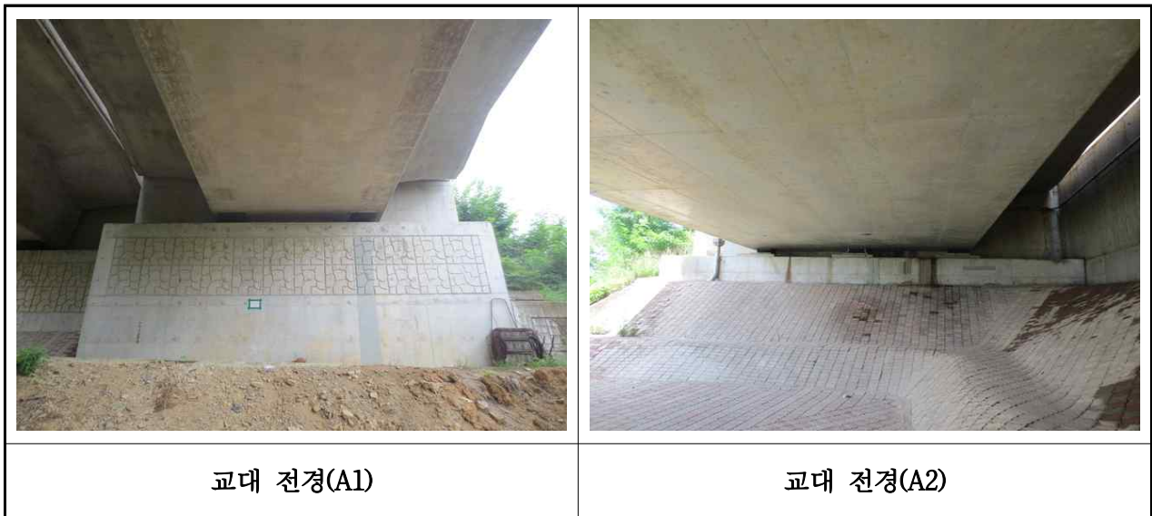
【사진 3.3.5】 교대 전경(부산)
