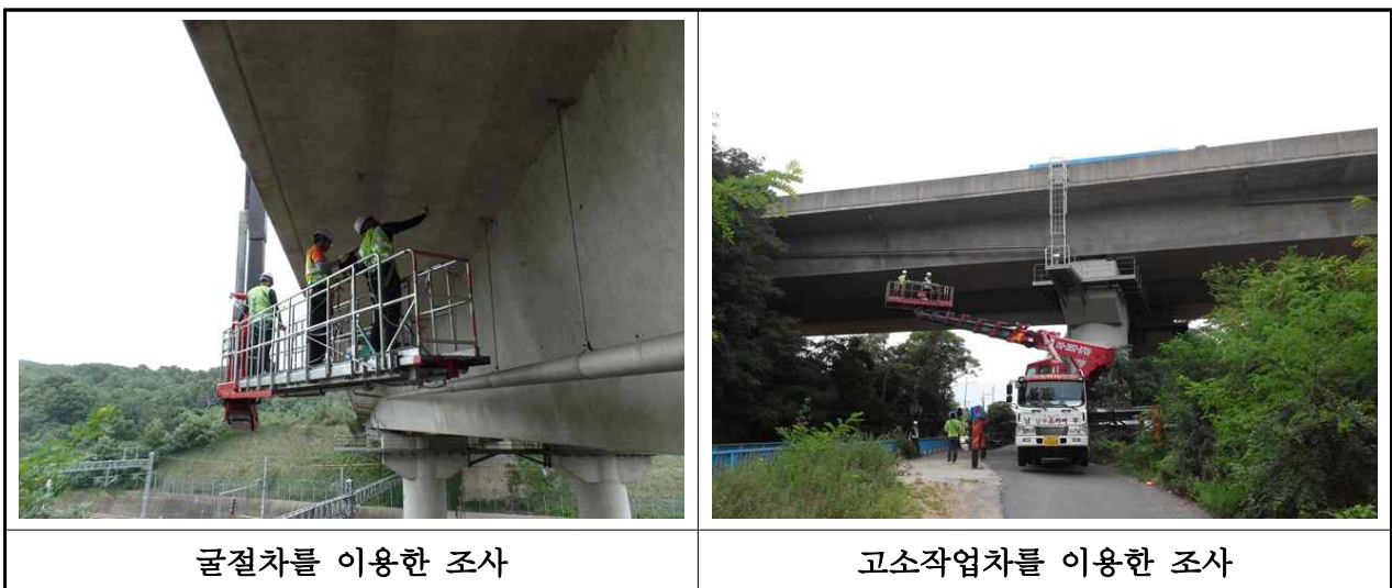
【사진 3.1.1】 교량점검차 이용한 근접 육안조사
