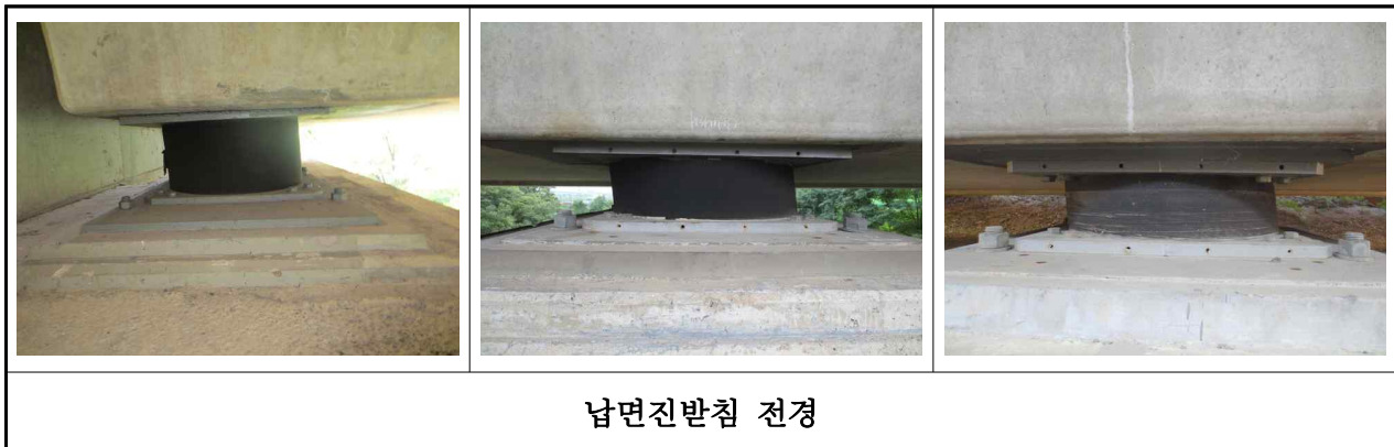
【사진 3.3.10】 교량받침 전경(부산)
